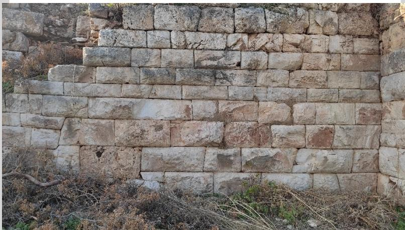
Şekil 49. Metropolis Akropolis batı sur duvarları iç cephesinde trapeziodal, isodomik ve pseudo-isodomik örgünün bir arada kullanımı (Kişisel Arşiv, 2022)
