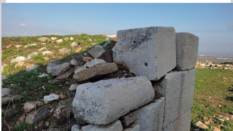
**Şekil 58.** Metropolis Akropolis surlarında batı duvarlarının dış cephesinde devşirme malzeme kullanımı (Kişisel Arşiv, 2022)
