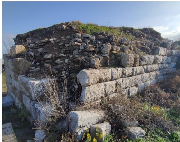
Şekil 46. Metropolis Akropolis batı sur duvarlarının dış cephesinde isodomik örgü
