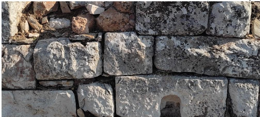
**Şekil 56.** Metropolis Akropolis surlarında doğu duvarlarının iç cephesinde devşirme malzeme kullanımı (Kişisel Arşiv, 2022)
